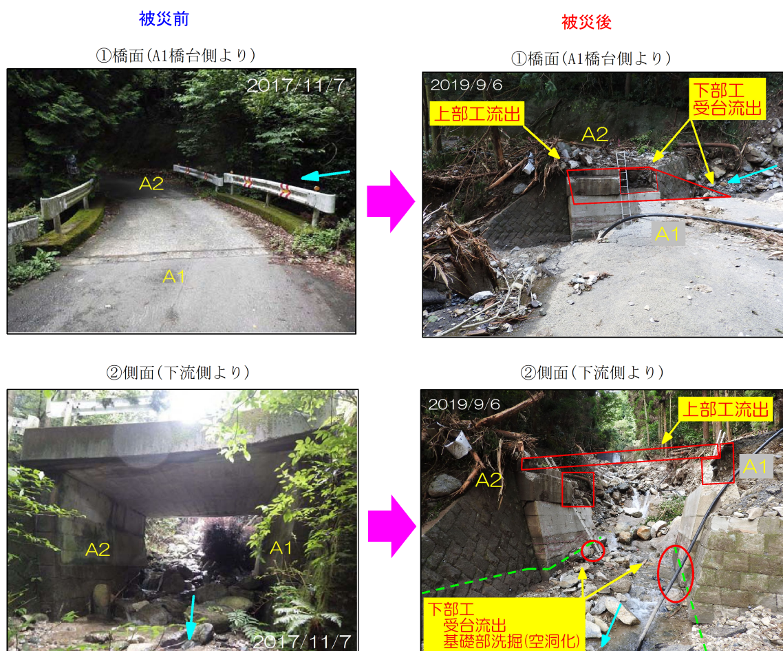
写真-1.1 被害状況写真（被災前との比較）
